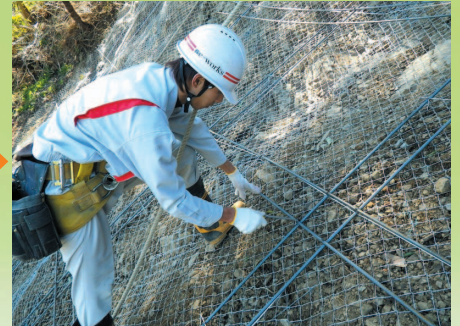
3 鉄筋組立工
