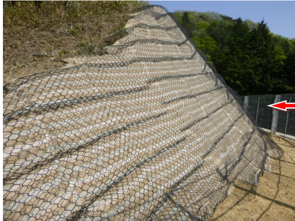
法面設置状況（近景）
