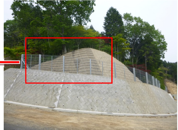
法面設置状況（遠景）
